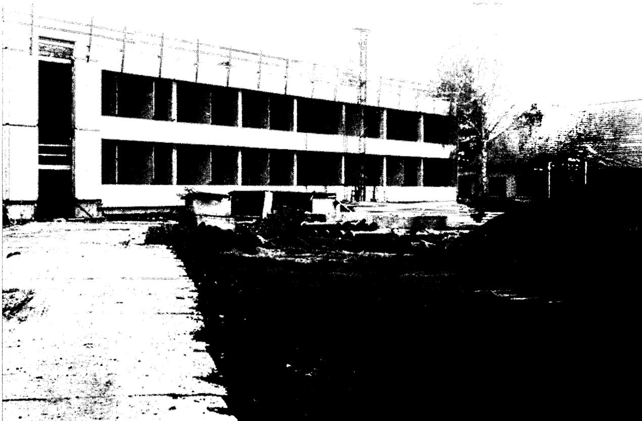
Výstavba nové budovy v letech 1983 – 1985
