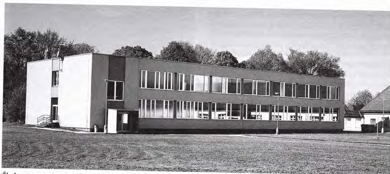
Škola po zateplení budovy v roce 2012
